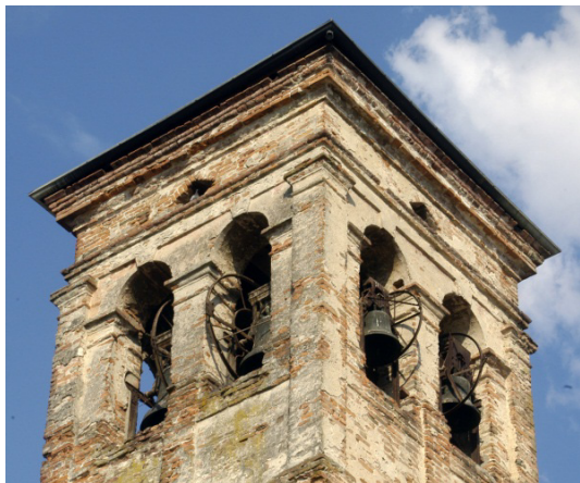
Fig. 5 – Particolare del campanile nell'agosto del 2008
