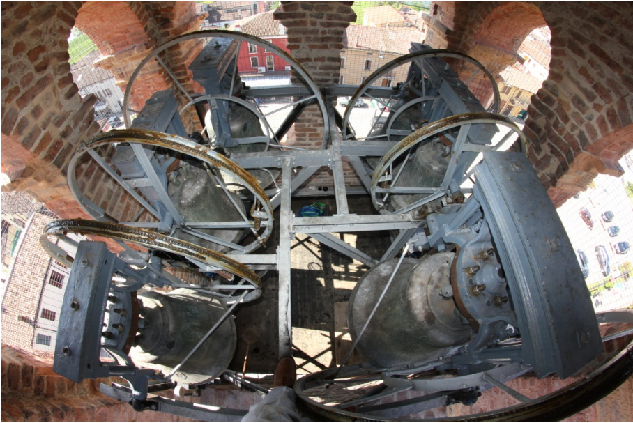
Fig. 21 – La nuova disposizione della campane e il relativo castello
