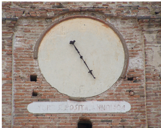
Fig. 2/a - L'orologio della torre campanaria prima del restauro del 2011
