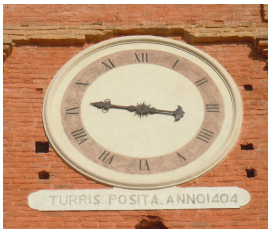
Fig. 2/b - L'orologio della torre campanaria dopo il restauro del 2011
