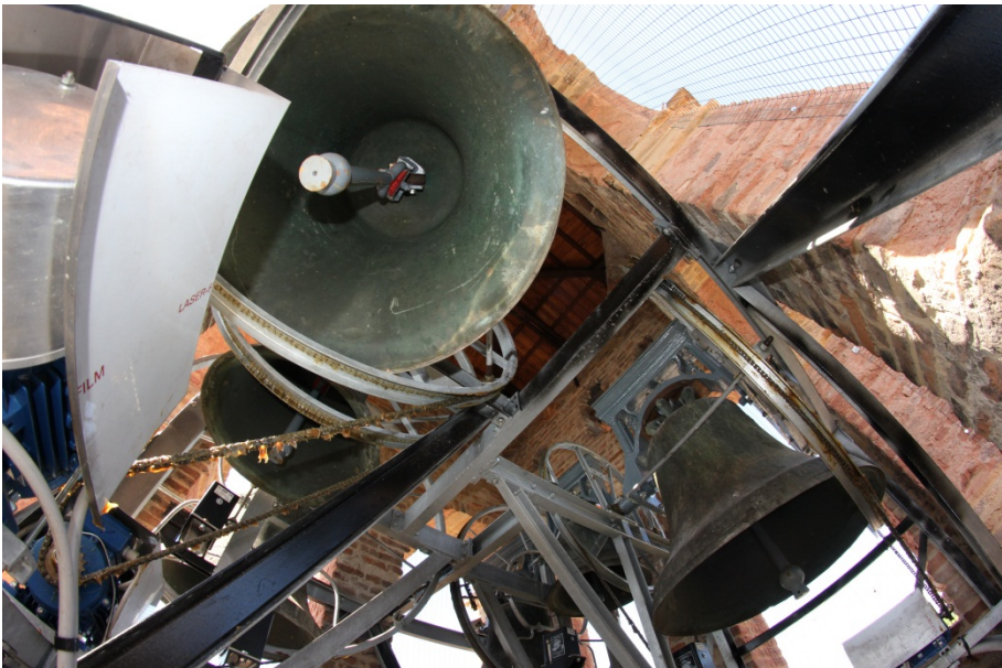
Fig. 24 – Particolare che evidenzia la manutenzione al battaglio (campana dei defunti)
