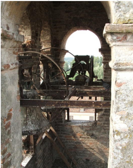
Fig. 6 – Particolare della cella campanaria: le condizioni del castello e delle campane prima dei lavori di restauro (foto di Massimiliano Furini)
