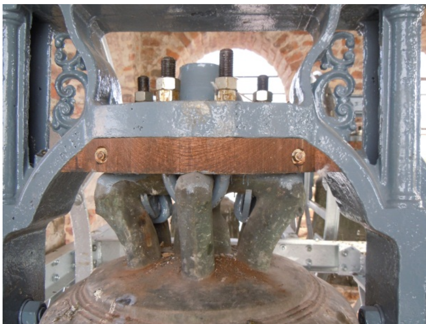
Fig. 11 - Le corone delle campane sono tutte costituite da sei braccia disposte in forma esagonale
